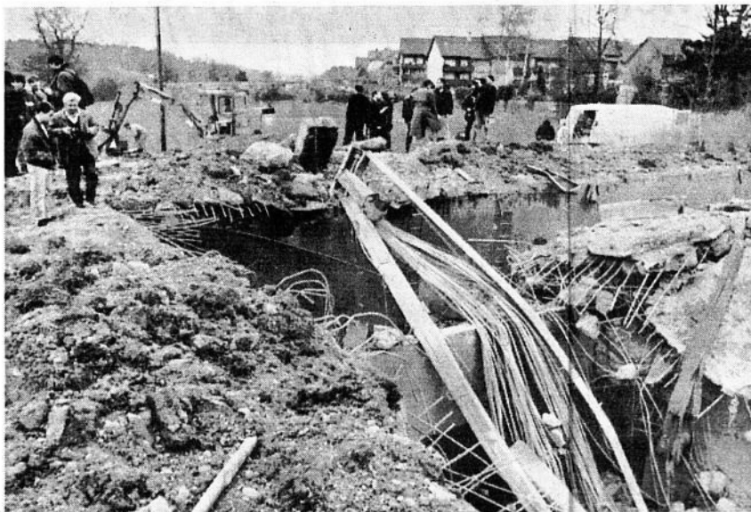
Bis in die weitere Umgebung kam es zu grossen Schäden. Im Bild die Ruine des Regenklärbeckens Reckenholz. (key)
