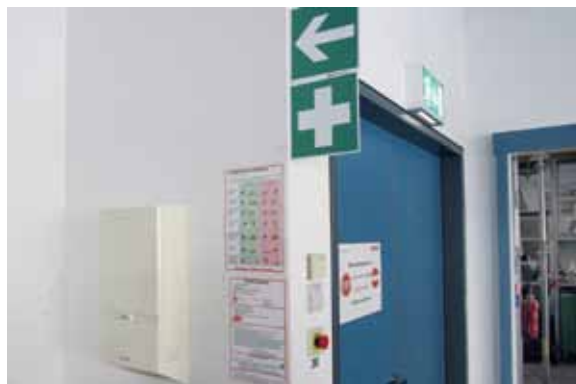
(11) Ordnungsgemäße Anordnung von Sicherheitsleuchten über einem Notausgang (FH Joanneum, Graz)
