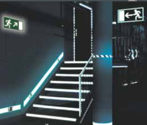
Lang nachleuchtende (Licht speichernde) Elemente verdeutlichen den Verkehrsweg (System Everglow, www.brandschutzservice.at )
