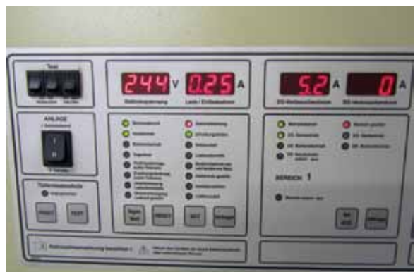
Zentralbatterieanlage...
