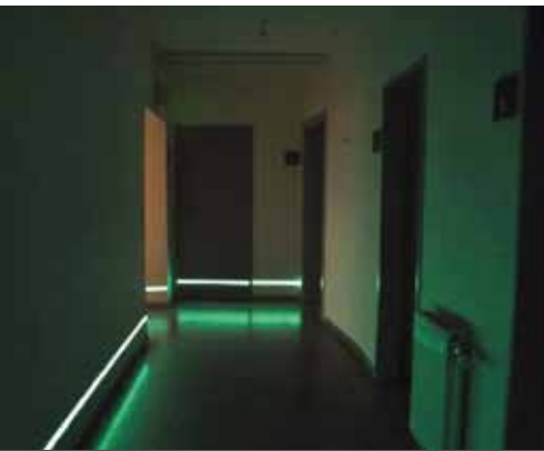
Lang nachleuchtende (Licht speichernde) Elemente verdeutlichen den Verkehrsweg (System Everglow, www.brandschutzservice.at )
