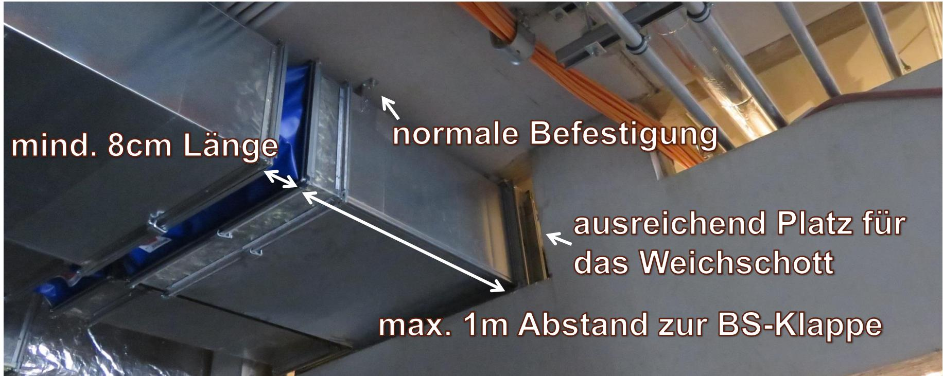
Voraussetzung dafür ist, dass durch Maßnahmen der Dehnungskompensation die im Brandfall durch Wärmedehnung oder Absturz der anschließenden Luftleitungen entstehenden Kräfte soweit herabgesetzt werden, dass die Lage der Brandschutzklappe/Brandrauch-Steuerklappe in Bezug auf den brandabschnittsbildenden Bauteil über die Feuerwiderstandsdauer nicht verändert und die abschottende Wirkung des Weichschotts nicht beeinträchtigt wird.
